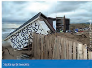
Dégâts après tempête
