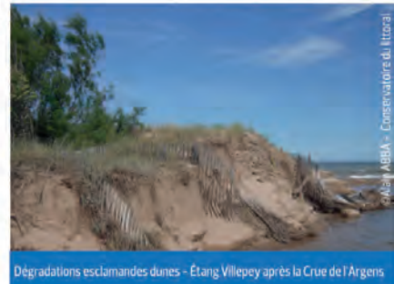
Dégradations esclamandes dunes - Étang Villepey après la Crue de l'Argens
