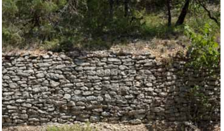
► Soutènement en pierre au Montat (46)
