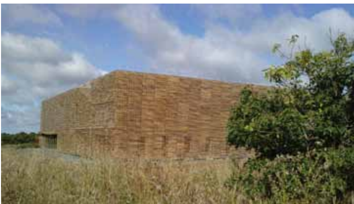
► Un exemple de volume simple bardé en bois adapté à un contexte rural - Hôtel d'entreprise à Puceul (44) - GLV architectures - © Ph. Ruault
