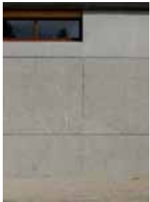
► Exemple Béton sablé brut à Pontarlier (25)- F. Haton - architecte
