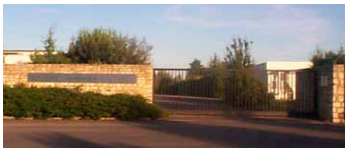
► Entrée d'un bâtiment industriel à La Ferté-Bernard (72) - Agence HYL paysagistes
