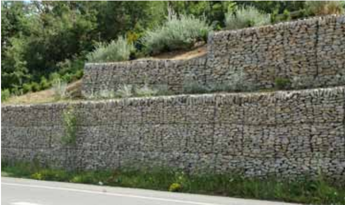
► Soutènement réalisé en gabions - Mercuès (46) - «un pour cent paysages» paysagistes
