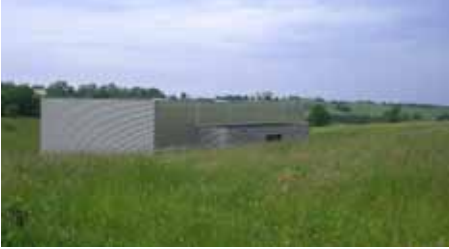
► Un traitement sobre des façades participe à une insertion paysagère subtile - Halle des Sports - Labastide-Murat (46) architectes : F. Coq & H.Lefrancq
