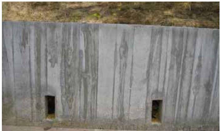
► Exemple de soutènement en béton banché au Vigan (46) - M. Favresse architecte
