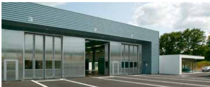
► Bureau de Contrôle des véhicules à Saint Herblain (44) P. Joly architecte - © S.Chalmeau
