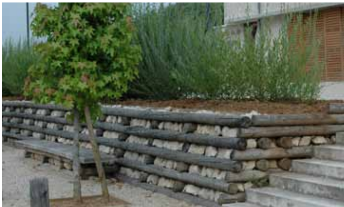
► Exemple de soutènement utilisant le bois à Caillac (46) - P. Bosc architecte
