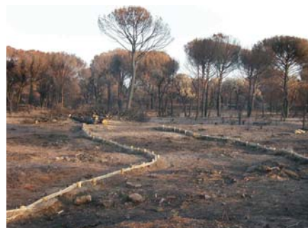
FASCINAGES SUR LA MARE L. MARSOL - ONF DU VAR
