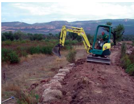
TRAVAUX DE CONFORTEMENT DU BOURRELET L. MARSOL - ONF DU VAR
