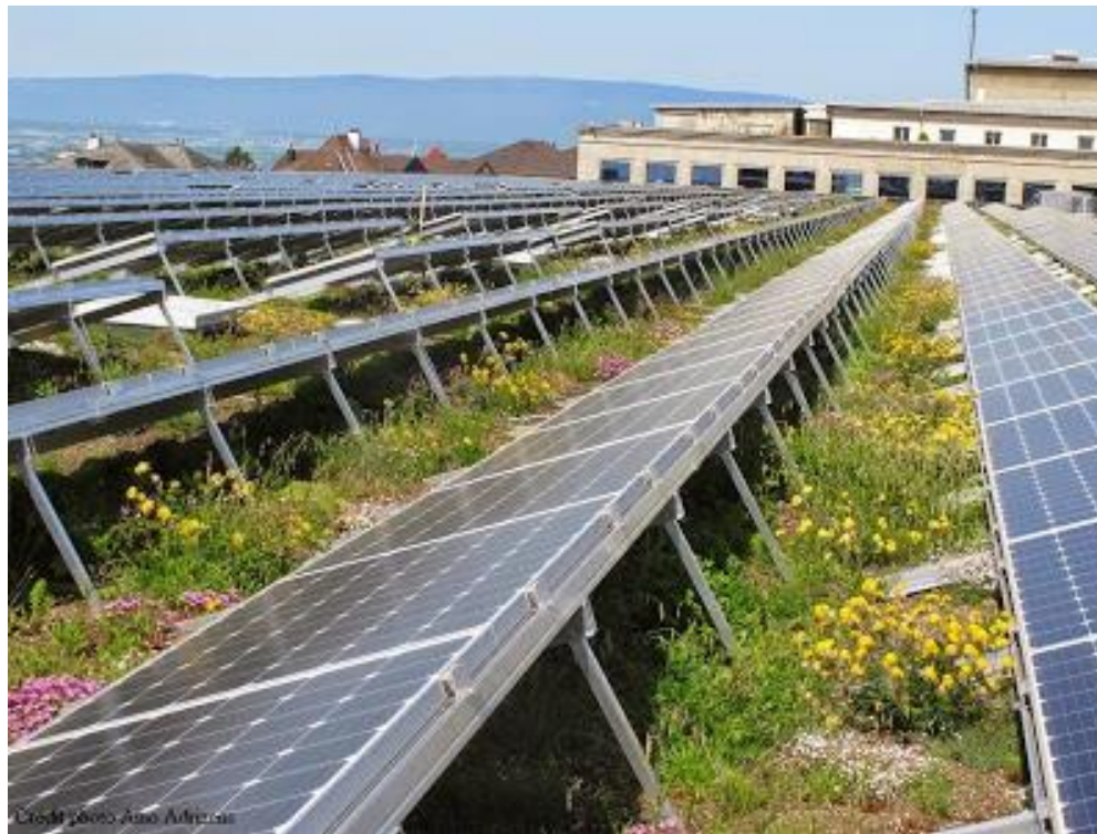
Halles Beaulieu, Lausanne Suisse – Toiture biosolaire Crédit Photo Aino Adriaens
