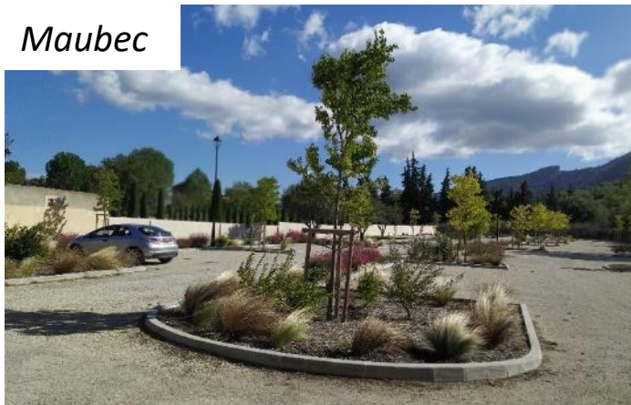
Parking perméable stabilisé
