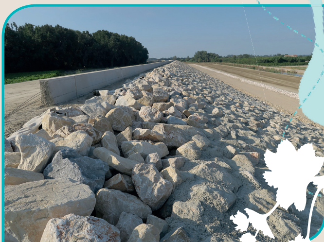
Digue résistante à la surverse entre Beaucaire et Fourques (en cours de construction)
