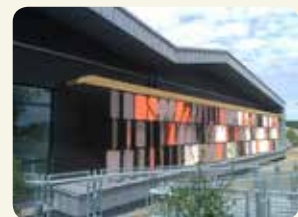
Maître d'ouvrage : FFB Compiègne
